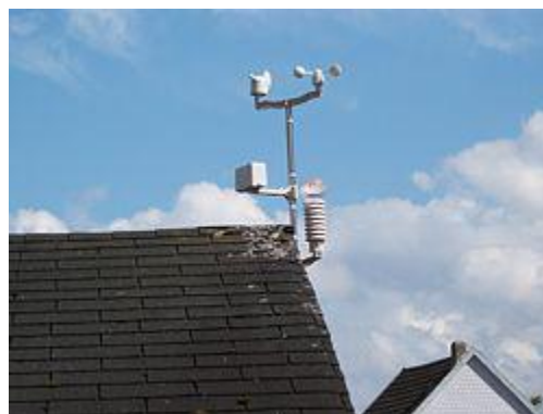
Montage der Sensoren der Wetterstation an einer Gartenhütte
