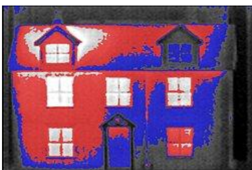
Wärmebildaufnahme einer Gebäudefassade
