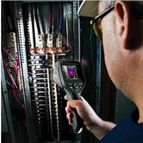
Temperaturkontrolle von elektrischen Bauteilen mit einer Wärmebildkamera der Flir-Ebx-Serie
