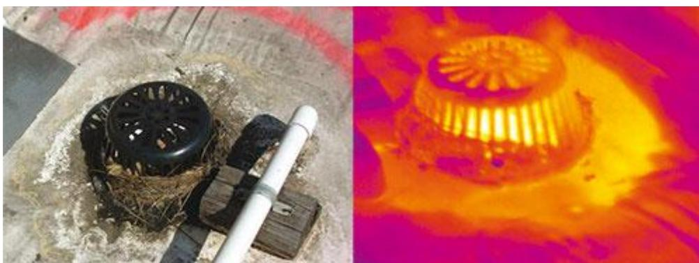
Das Infrarotbild zeigt Wasserlecks im Bereich der Eindichtung an der Dachentwässerung.
