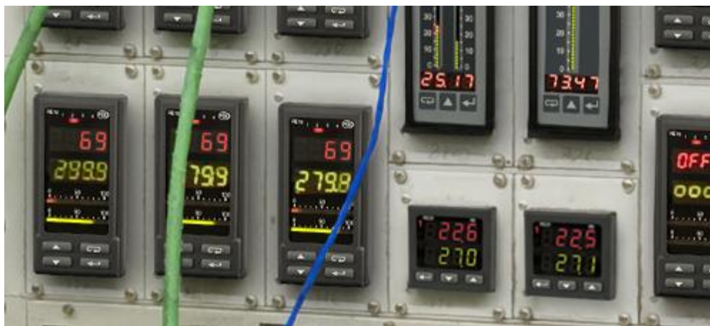
Der Universalregler PCE-RE15 zusammen mit Bargraphanzeigen vom Typ PCE-NA5 und PCE-NA6 und dem Universalregler PCE-RE26 eingebaut in einer Schalttafel.
