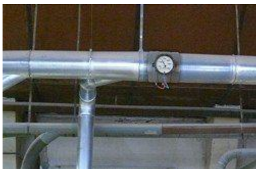
Hier sehen Sie den Strömungsmesser PCE-VR in einem Rohrleitungssystem eingebaut.
