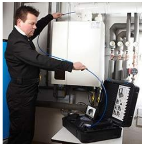
Zu sehen ist die Anwendung vom Endoskop VIS 300 / 350 an einer Heizungsanlage
