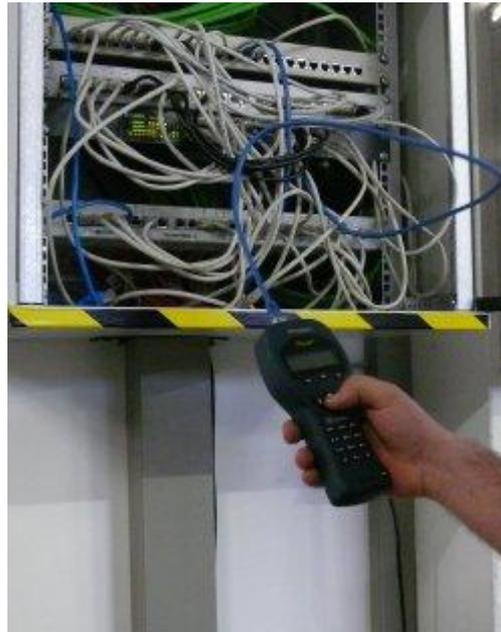
Hier ist der Pinger Plus bei einem Netzwerk-Test zu sehen, bei dem neben anderen Tests auch nach doppelten IP-Adressen im Netzwerk gesucht wird.
