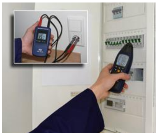
Das Kabelsuchgerät PCE-CL 10 im Einsatz bei der Suche nach dem zu der Steckdose gehörenden Sicherungsautomaten
