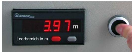
Auf einer Anzeige beim Silo können wahlweise die Leermeter oder der Füllstand in Prozent angezeigt werden.
