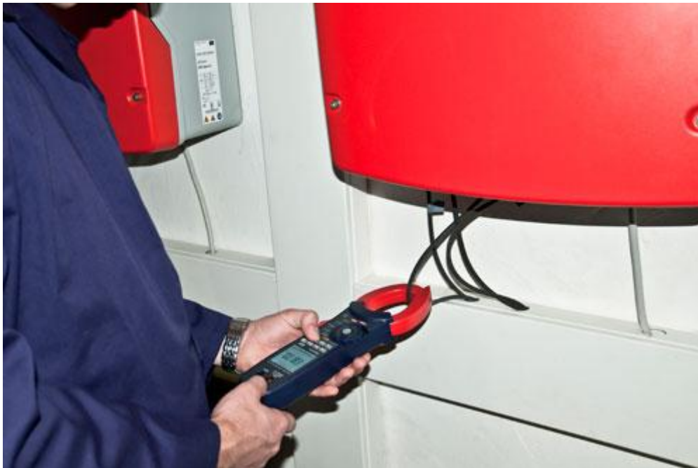
Hier sehen Sie die PCE-PCM2 bei einer Messung des Gleichstromes einer Solaranlage
