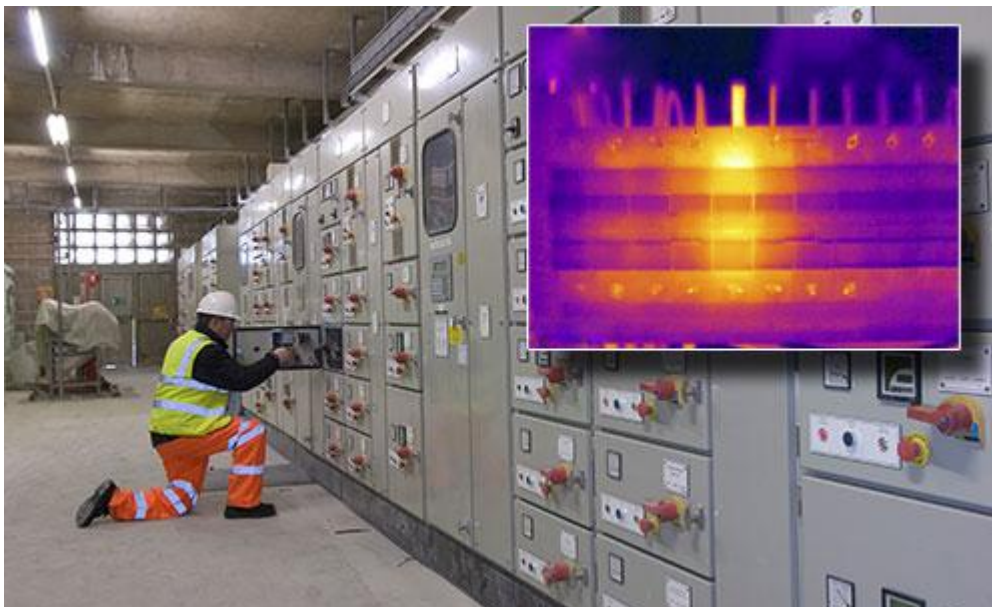
Die Wärmebildkamera PCE-TC 5 bei der Überprüfung von Schaltschranken
