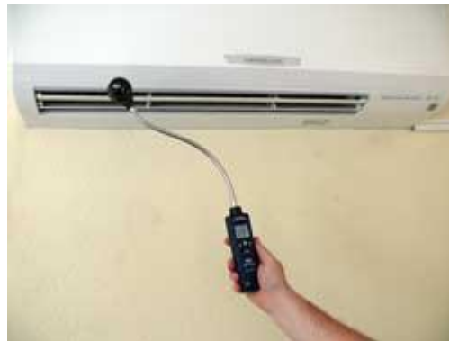
Das Thermo-Flügelrad-Anemometer bei der Messung an einer Klimaanlage
