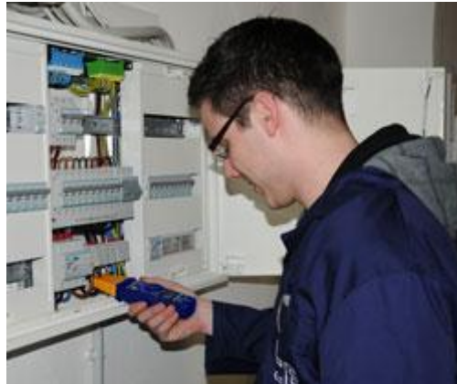
Hier sehen Sie wie mit der Strommesszange, in einem Schaltschrank, der Strom gemessen wird
