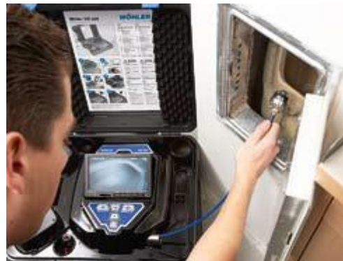
Hier sehen Sie das Endoskop PCE-V240 bei der Überprüfung eines Lüftungsschachtes
