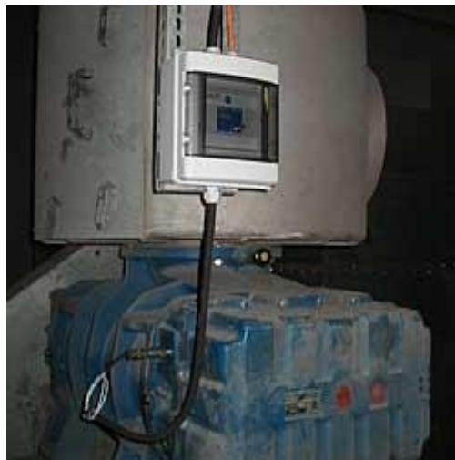
Hier sehen Sie den Piezo-Vibrationssensor an einer Verdichtungsmaschine
