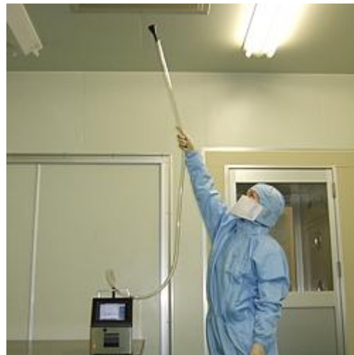
Hier sehen Sie den Luftpartikelzähler bei einer Untersuchung an einer Lüftungsanlage
