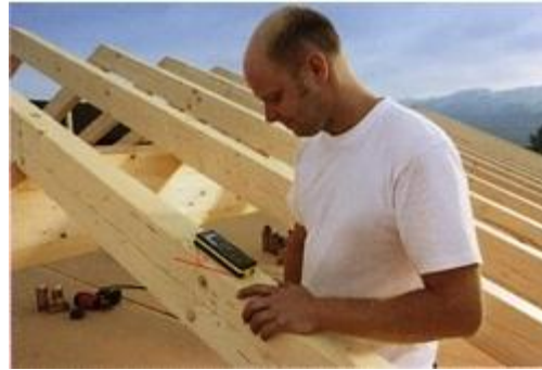
Lasermesser Leica Disto D5 mit integrierte Neigungssensor zum bestimmen von Winkeln
