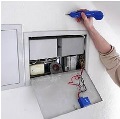
Klingelkabelverfolgung im Treppenhaus
