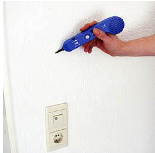
Kabelbruchsuche bei Unterputzleitungen
