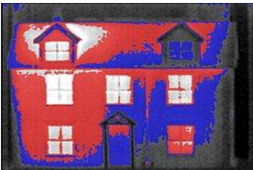
Wärmebilddaufnahme einer Gebäudefassade
