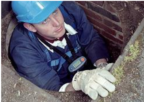
Personenschutz beim Begehen von Kanälen
