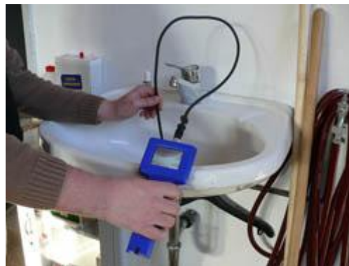
Betrachtung einer Verstopfung im Rohr
