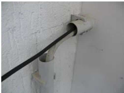
Betrachtung einer Kabelführung
