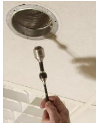
Lüftungskanäle können mit dem Endoskop untersucht und Schäden durch die Markierung an dem Schubkabel lokalisiert werden.
