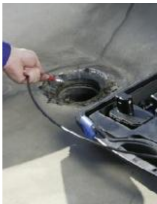
Hier sehen Sie das Videoskop bei der Untersuchung von Wasserleitungen / Abwasserleitungen in der Industrie.
