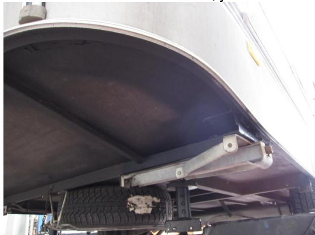
Wohnwagenboden: Hier massive Spanplatte, spärlich geschützt
